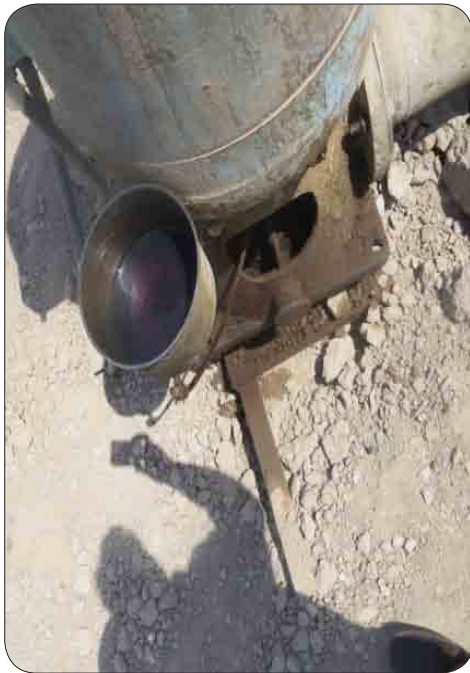
شکل ۱: مخزن روغن الکتروپمپ و نحوه روغنکاری شافت و غلاف آن
