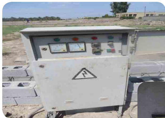
شکل ۲: تابلو برقی الکتروپمپ که در آن آمپرسنج سالم و ولتسنج خراب است.
