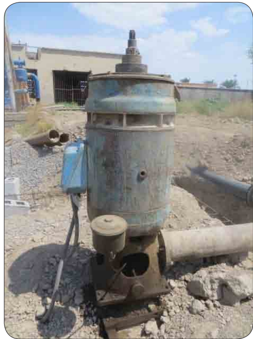
شکل ۱: مخزن روغن الکتروپمپ و نحوه روغنکاری شافت و غلاف آن
